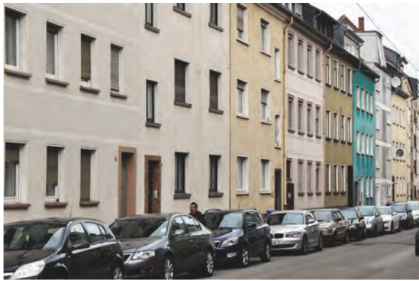
Abb. 59: Erdgeschosszone in der Gärtnerstraße
