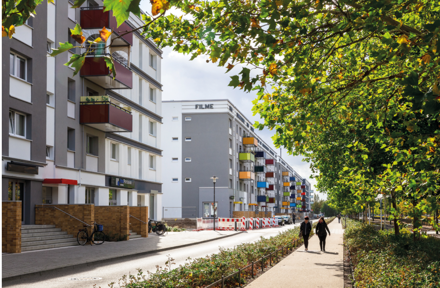
Abbildung 16: Wohnungsbau und Umfeld der ProPotsdam in der Konrad-Wolf-Allee nach umfassender Sanierung und Transformation des Gebiets in eine Gartenstadt (Quelle: Projektkommunikation Hagenau GmbH – Benjamin Maltry)
